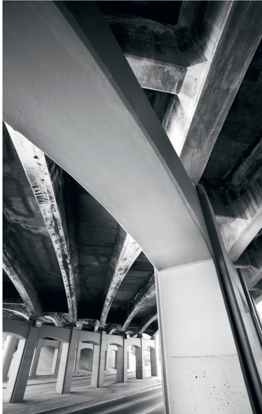
▲ Zdjęcie 4.: Przejazd podziemny
